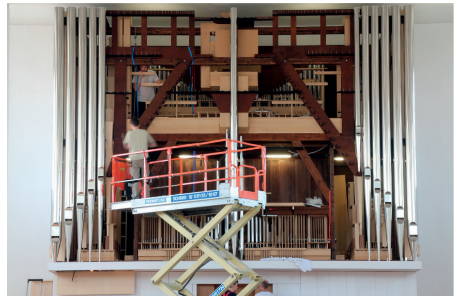
Die Prospektpfeifen werden erstmals eingebaut
