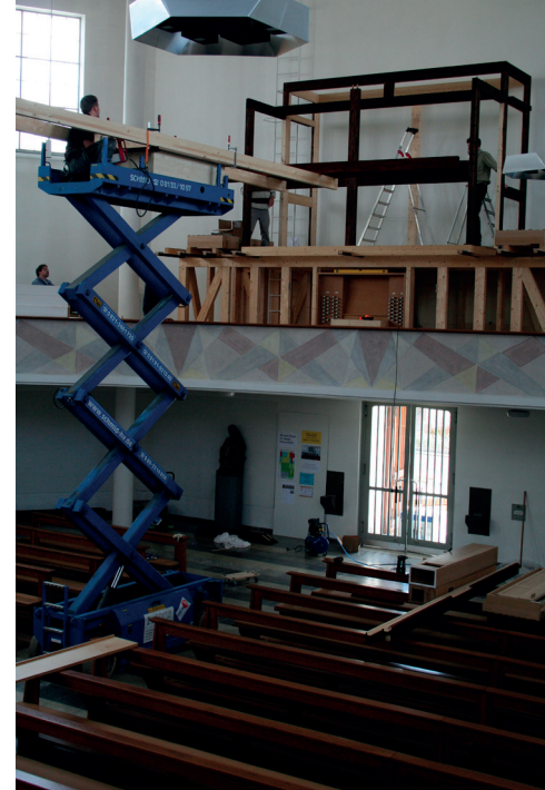
Mit einem Scherenhublift werden die großen Gehäuseteile auf die Empore gehoben
